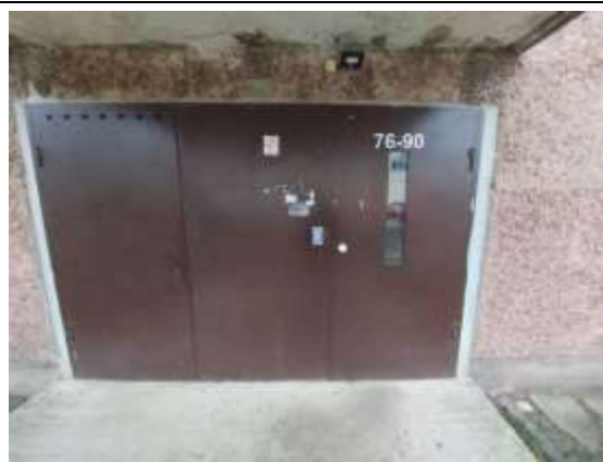
leeja kāpņu telpa
